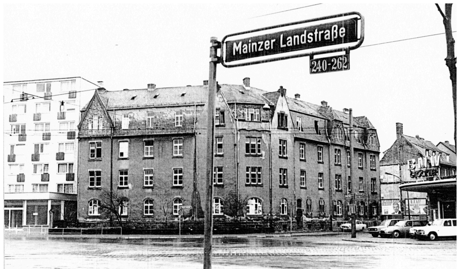
Wohnblock des „Fiskus Eisenbahn“ an der Galluswarte 1975, bald darauf abgerissen. Heute steht dort das Ärztehaus. (© ISG Renate Ullrich)
