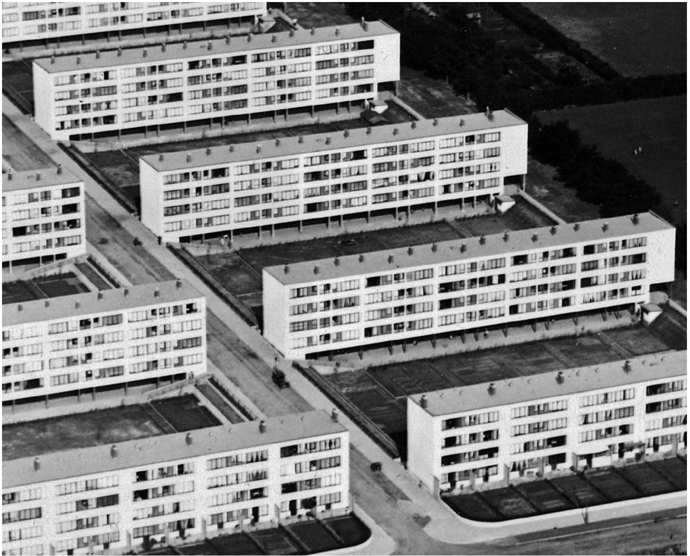
Stahlskelettzeilen des ersten Bauabschnitts, 1930 (Fotoausschnitt: unbekannt, ISG FFM STA 1998 Nr. 12277)
